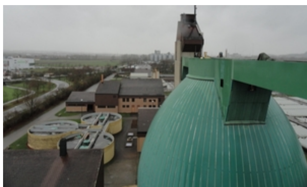
Blick vom Faulturm auf die Kläranlage. Foto: Katharina Pfaffel
